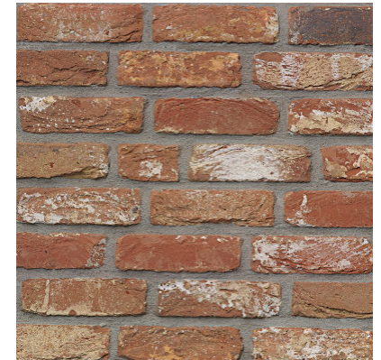
S1-00026-01 Backstein Gewölbe
